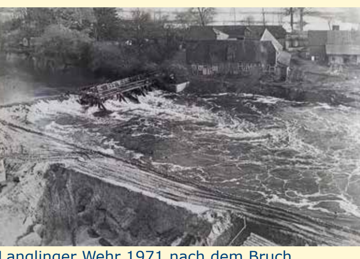
Langlinger Wehr 1971 nach dem Bruch
